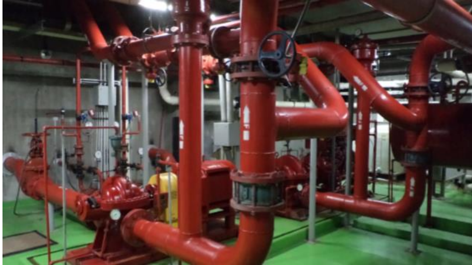
ภาพแสดง : เครื่องสูบน้ำดับเพลิง (Fire Pump) และท่อเย็นของโครงการ
